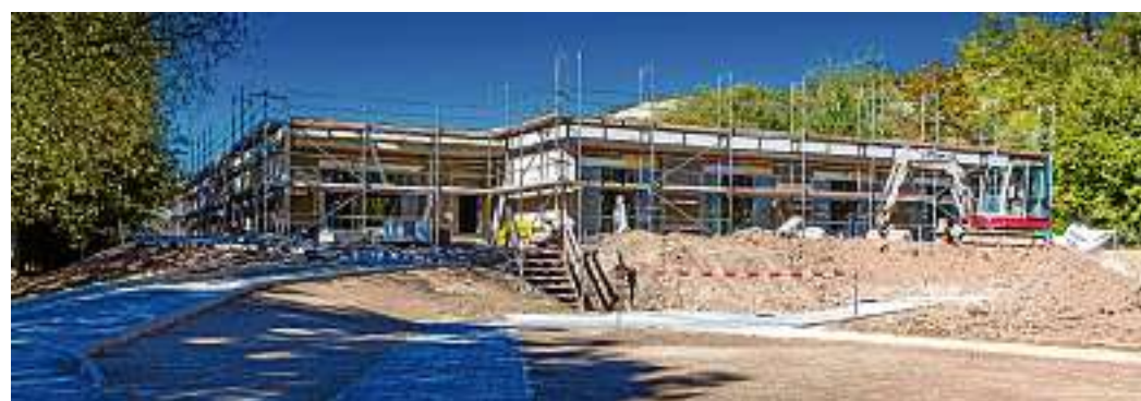
Die Baustelle des stationären Hospizes in der Paul-Schneider-Straße, Lobeda-Ost, wie sie vor wenigen Wochen aussah. Foto: Jenawohnen/Grafiker.org
